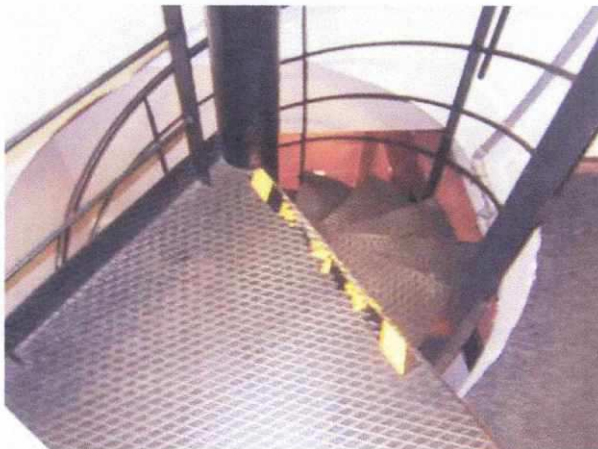
Kovové točité schodiště do podkroví
