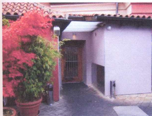
Vchod k restaurační kuchyni
